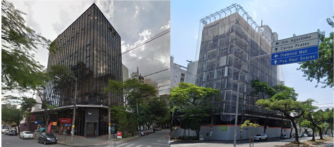
Figura 1 - Fachada do Edifício Carmo Couri antes do retrofit (outubro 2018) e durante a reforma (outubro 2023)
