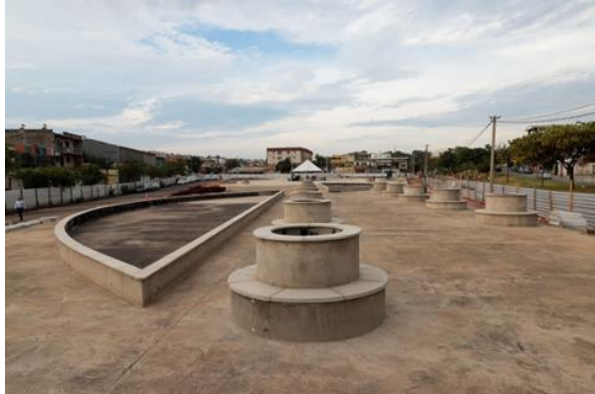
Figura 1 - Bacia de retenção Rio Volga B2 – Contagem
