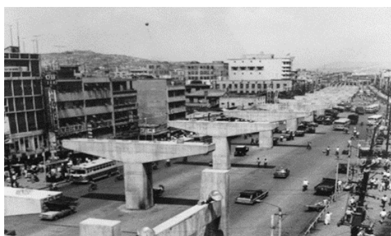
Figura 4 - Leito carroçável que encobriu o rio ainda em fase de construção do viaduto
