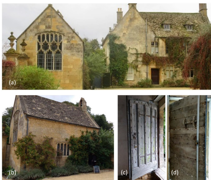
Figura 2 – Hidcote: (a) capela à esquerda e casa principal à direita; (b) vista lateral da capela; (c) vista externa da porta principal; e (d) vista interna da porta principal
